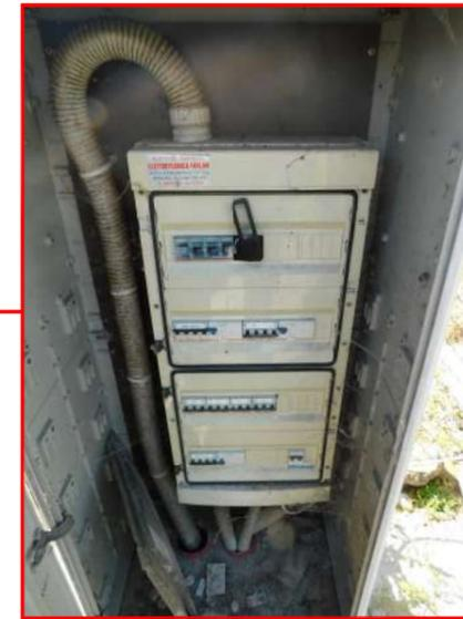
Centralino da esterno parete in materiale plastico, in versione "stagna", colore grigio RAL7035, adatto a contenere fino a n°72 u.m. su n°4 file, grado di protezione IP65, classe di isolamento II, già esistente e da mantenere previa sostituzione del pannello con portine frontali
